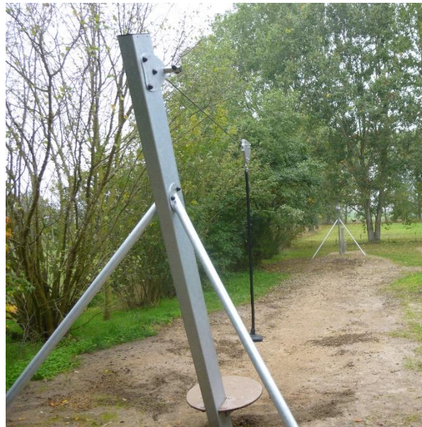
Die Neuinstallation der Seilbahn auf dem Spielplatz in Buskow
