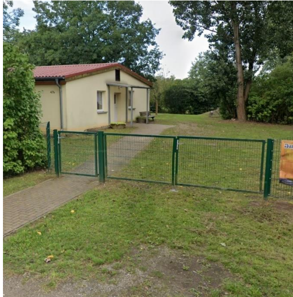
Das Dorfgemeinschaftshaus in Buskow erhält zwei Unterstände für den Außenbereich
