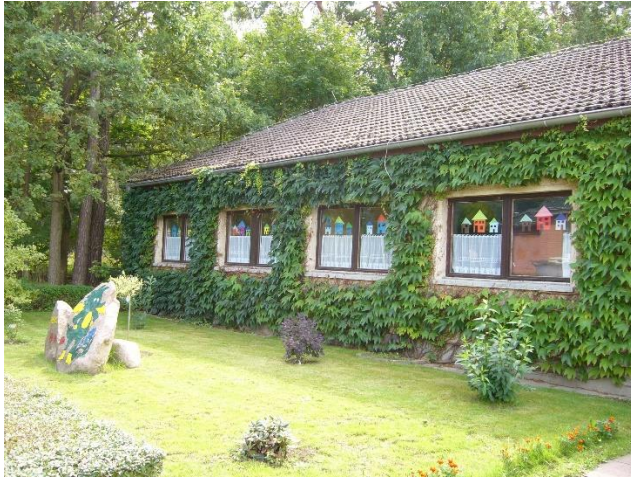
Foto: Kita Tabaluga vor Beginn der Baumaßnahme
